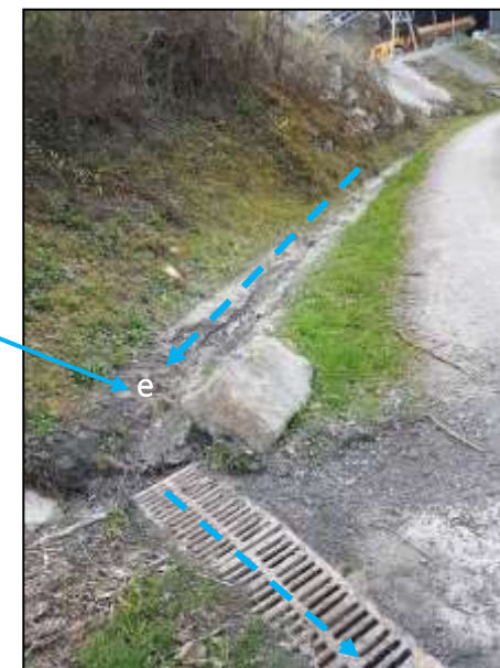
PL.10 Illustration du drainage de la piste interne Est
