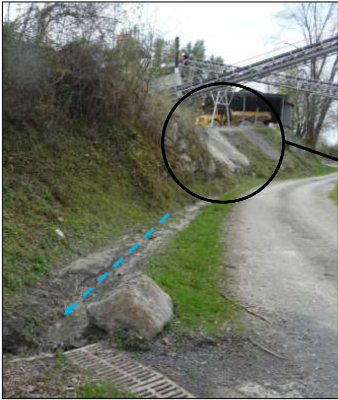
PL.11 : Illustration du drainage de l'eau pluviale de la plate-forme du groupe tertiaire
