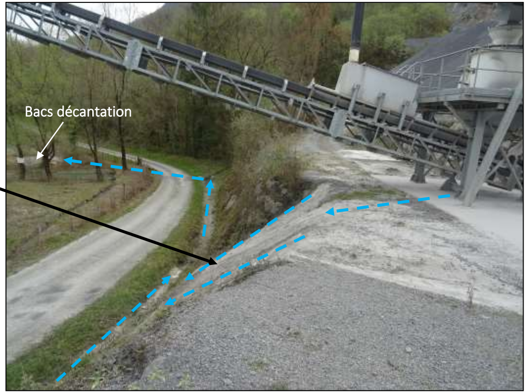
PL.11 : Illustration du drainage de l'eau pluviale de la plate-forme du groupe tertiaire
