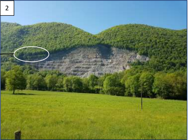
2. Vue depuis la D.918 Noter l'écran visuel que forme la galerie arborée de l'Ourtau, pour la partie basse du site
